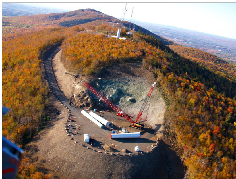
Fot. 1. Stawianie konstrukcji turbiny wiatrowej. Mars Hill, Maine, USA.
