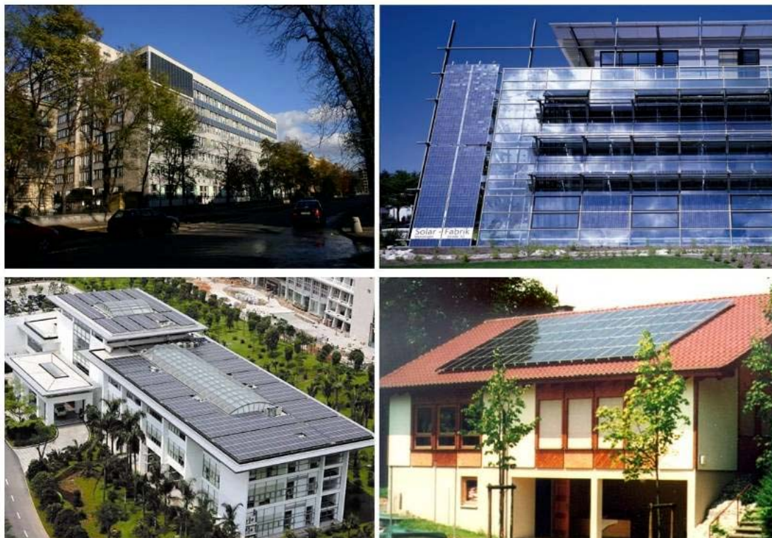
Rys. 11. Przykłady fotowoltaiki zintegrowanej z budownictwem (BIPV) (w lewym górnym rogu systemy na Politechnice Warszawskiej)
